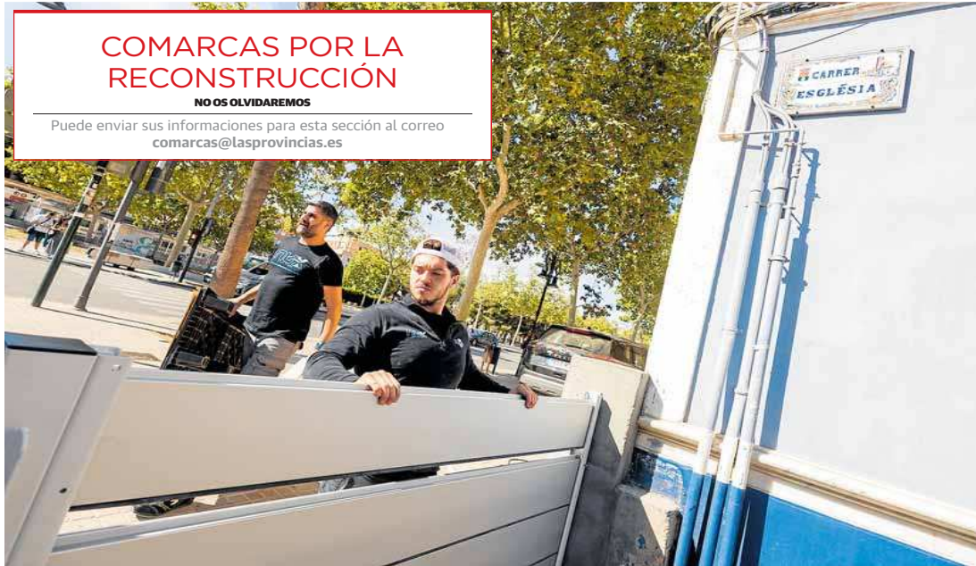
Colocación de las compuertas para su prueba este miércoles en una calle de Aldaia. JOSÉ LUIS BORT
