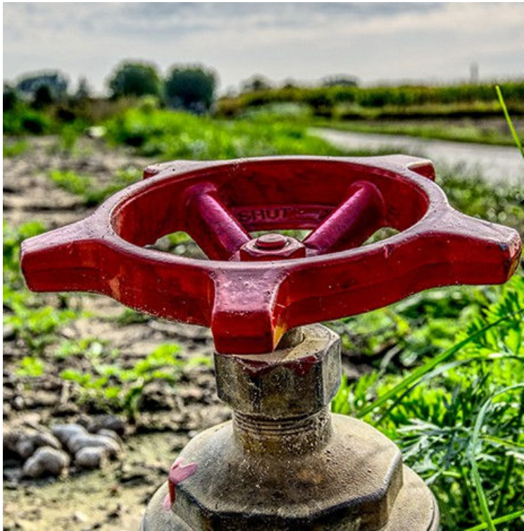
Inician obras para mejorar el abastecimiento de agua en Monte de los Jarales
